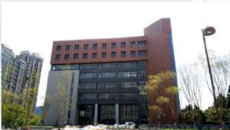
音律電機資訊大樓現況
